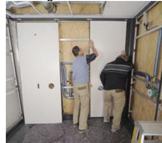
Einhängen der Wandverkleidung
