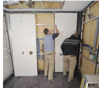
Einhängen der Wandverkleidung
