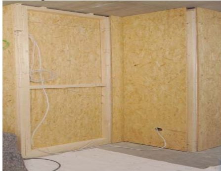
Montage der Trockenbauwände und Einziehen der gesamten Elektroleitungen
