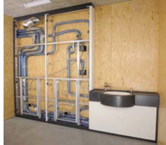
Einhängen der Wandverkleidung
